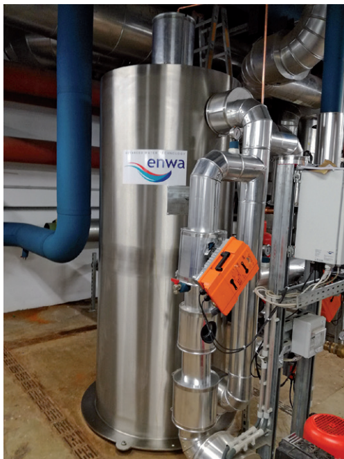
EnwaMatic® BS 500 in Edelstahlausführung isoliert im Doppelmantel. Foto: Christian Barth
