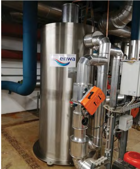
EnwaMatic® BS 500 in Edelstahlausführung - isoliert im Doppelmantel
