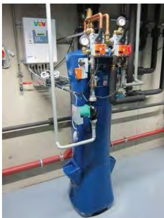
Einbau der EnwaMatic® als Bypass im Technikurm der Kälteanlage K40
