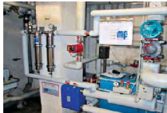
Die Einbindung eines EnwaMatic®-Bypassfilters in ein vorhandenes Heizsystem ist jederzeit möglich. ihrer
