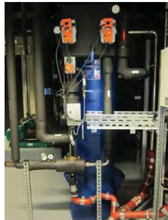
Einbau der EnwaMatic® als Bypass im Technikurm der Kälteanlage K8
