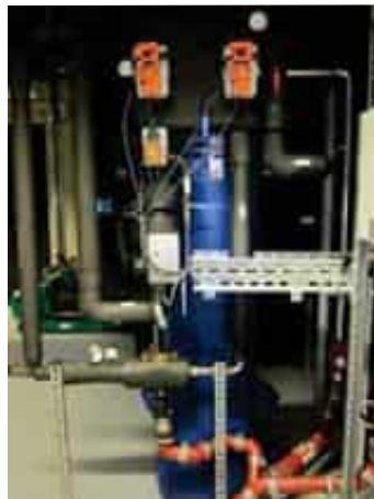
Einbau der EnwaMatic® als Bypass im Technikurm der Kälteanlage K8
