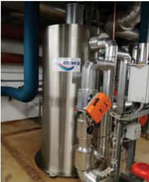
EnwaMatic® BS 500 in Edelstahlausführung - isoliert im Doppelmantel
