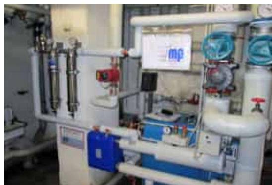
Die Einbindung eines EnwaMatic® Bypassfilters in ein vorhandenes Heizsystem ist jederzeit möglich
