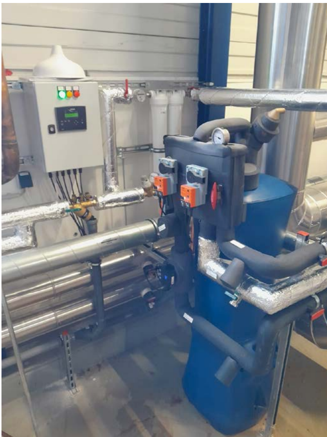
Bild 1: Das Systemfluid wird permanent durch die fünf Filtermedien der EnwaMatic geleitet.
